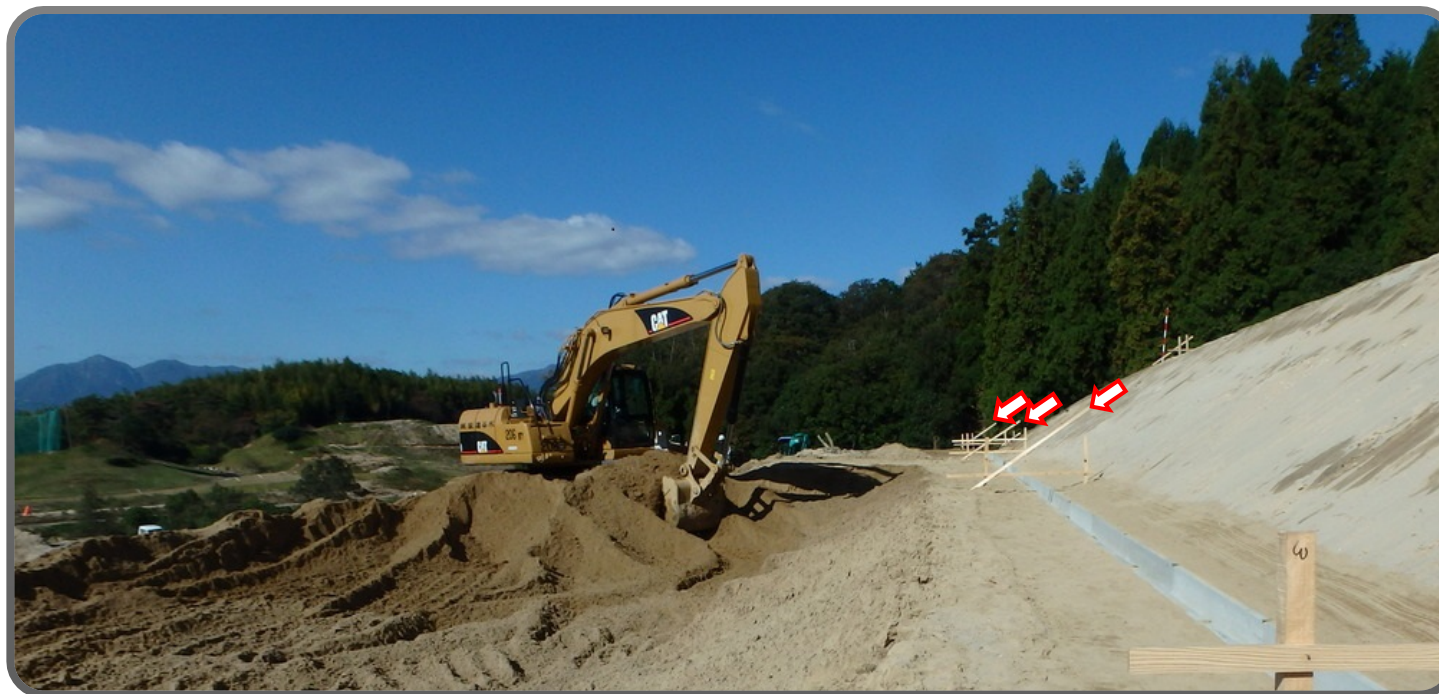
従来法面整形作業：バックホウ
