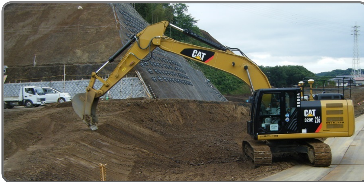
3D対応機械法面整形作業：バックホウ
