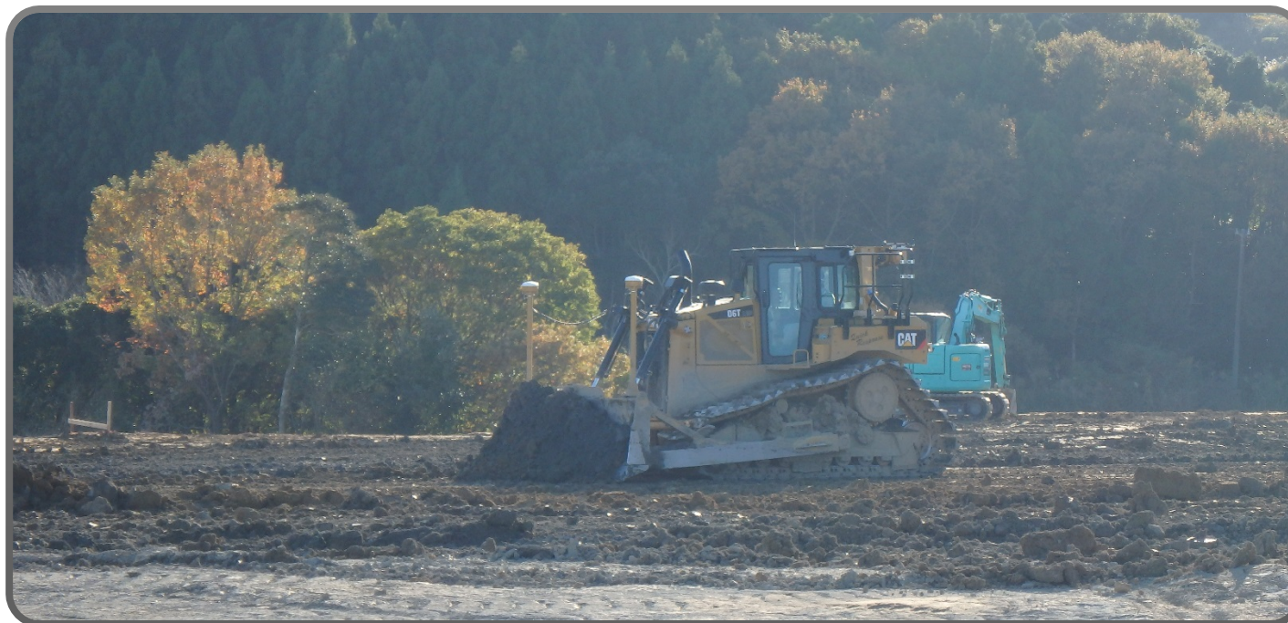
3D対応機械整地作業:ブルドーザー
